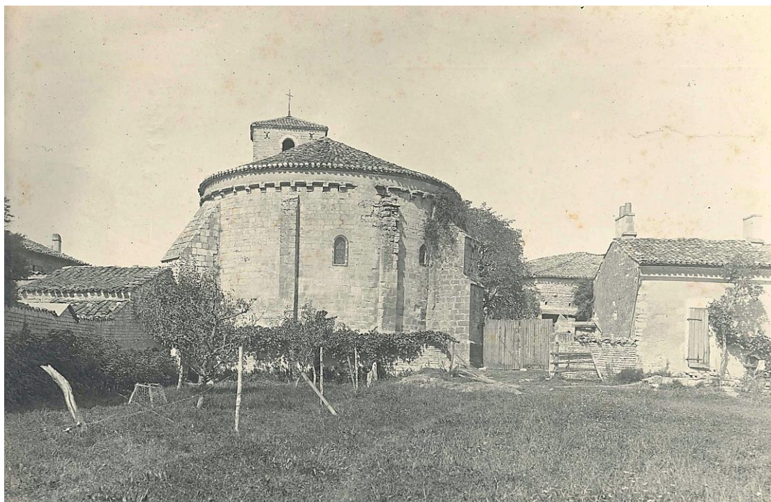
3. Le chevet de l'église et les vestiges du prieuré avant construction du Clos Mondésir (fin 19 e ou début 20 e ). Arch. Au Fil du Temps, fonds Laborde
