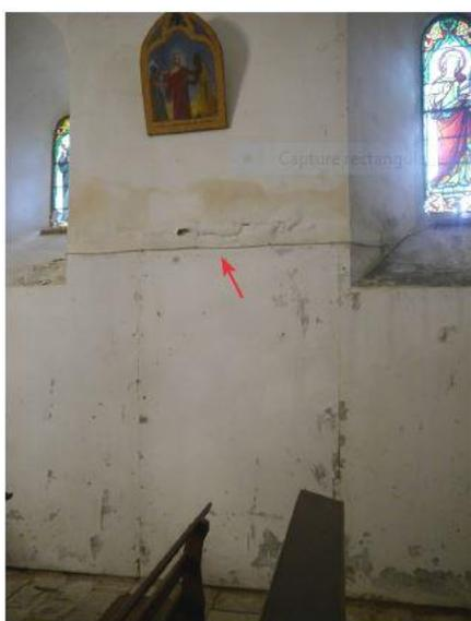
*Plaques fibrociment en partie basse des murs, frange de capillarité (enduit cloqué)*
