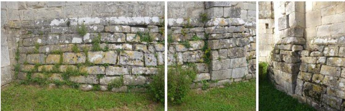
*Soubassement taillé : cœur de maçonnerie évidé et assises désorganisées, développement important de la végétation dans les joints de pierres*
