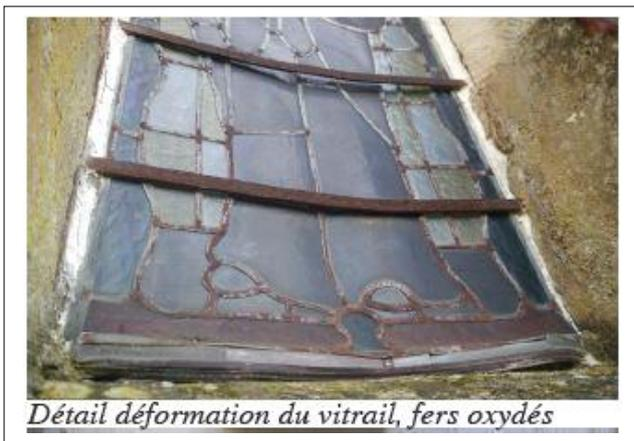
*Détail déformation du vitrail, fers oxydés*
