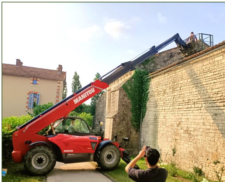
L'inspection de la charpente a eu lieu le 30 juin. Photo J.-Louis Jonquet
