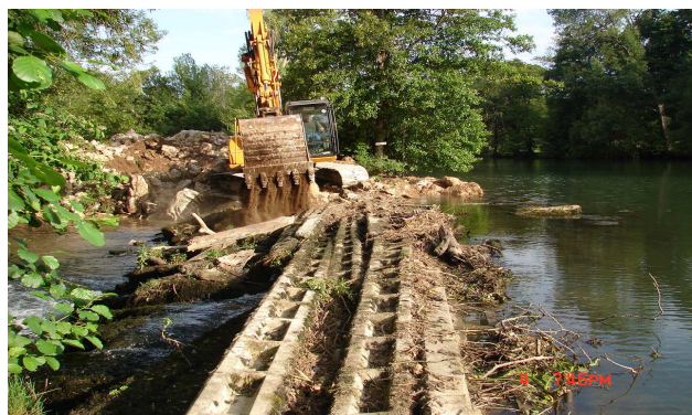
La digue pendant les travaux
